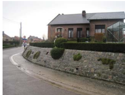
Talud met klinkers
