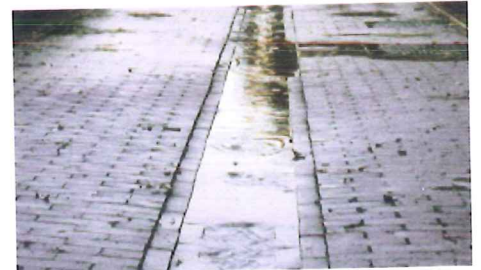
03_De molgoot voor zichtbaar afvoeren water
