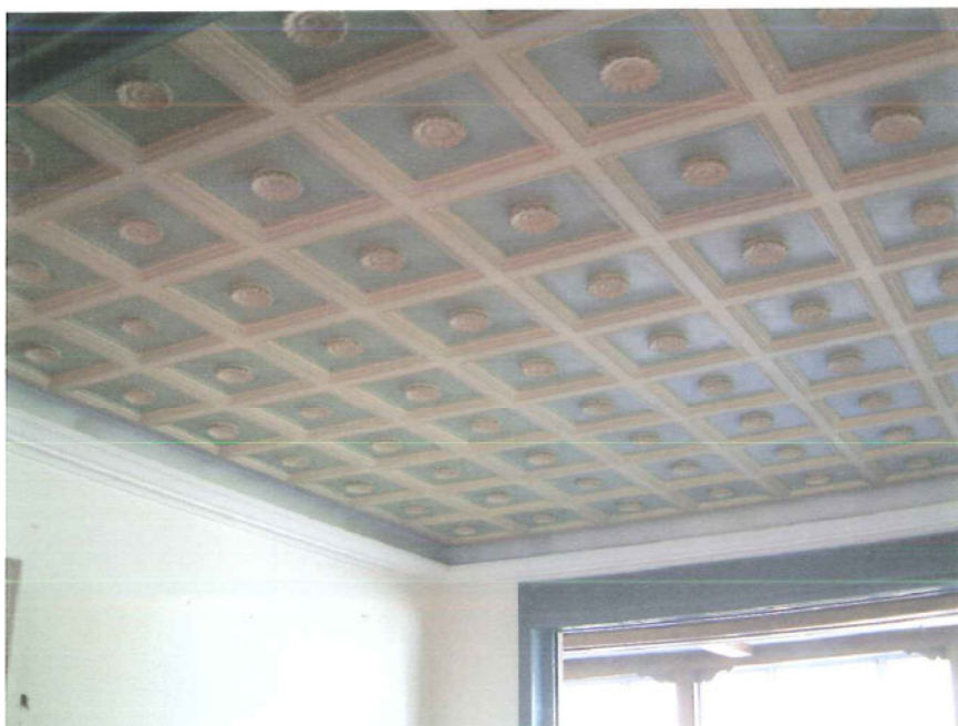
Het gedecoreerde plafond wordt gerestaureerd.
