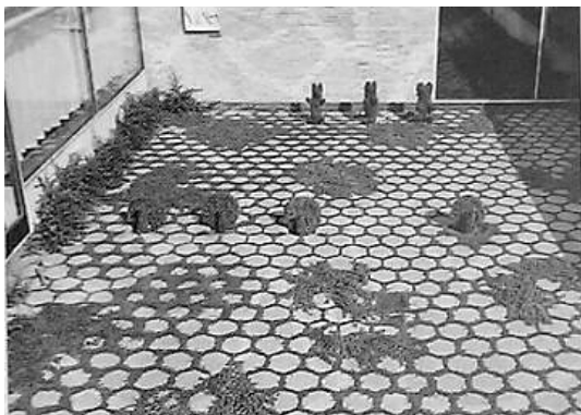
Fig 13. Buitenverharding betontegels in volle grond
