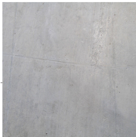
betondallen voor de speelplaatsen
