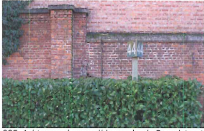
005_Achtergevel spoorzijde van loods Bareelstraat
