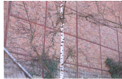
006_Muur van de loods aan de Bareelstraat
