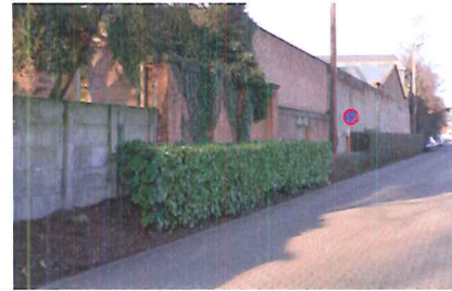
005_Muur van de loods aan de Bareelstraat
