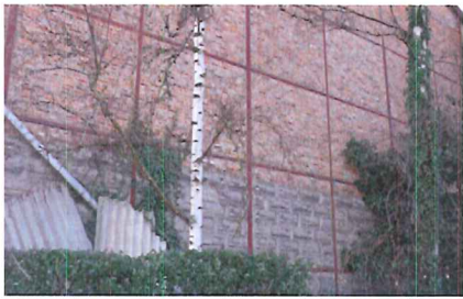
003_Achtergevel spoorzijde van loods Bareelstraat
