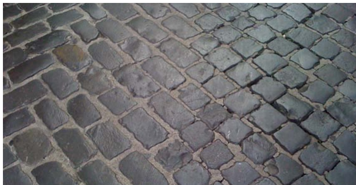
③ Verschillende kasseien bestrating voor verschillende weggebruikers
