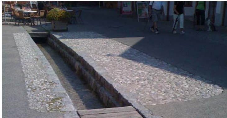
12 Waterloop die het marktplein en de Zwanebeek verbind
