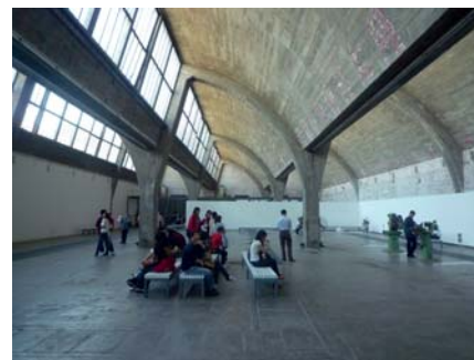
Met specifieke uitwerking noorderlicht komt binnen via de sheddak constructie
