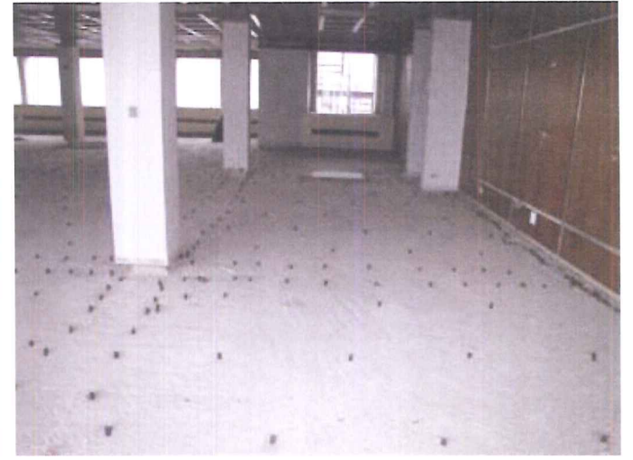
Versterken vloerplaat bovenzijde beugels (project Alix Gent 2011)
