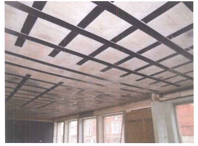
Versterken vloerplaat onderzijde (project Alix Gent 2011)
