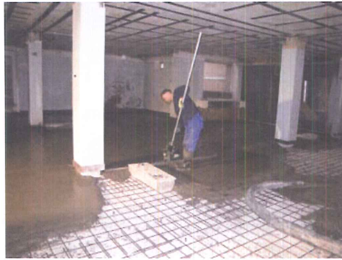
Versterken vloerplaat bovenzijde opstortlaag (project Alix Gent 2011)
