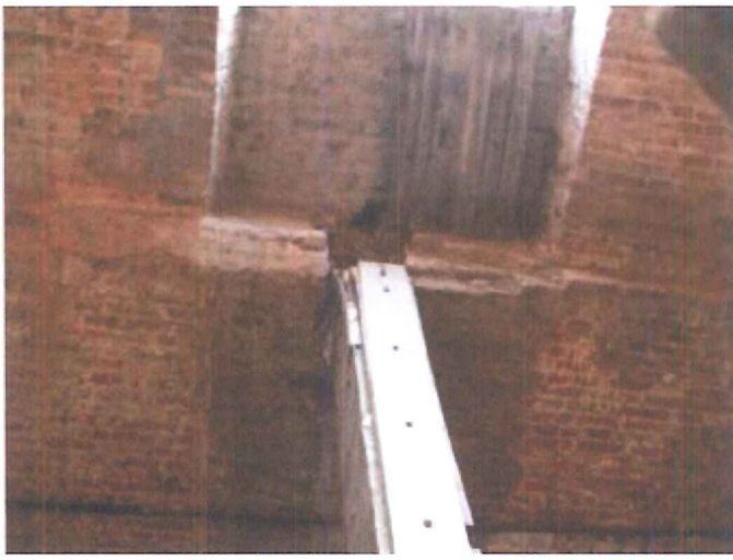
Versterken houten balk staalplaat (Poortgebouw Abdij Herkenrode 2005)
