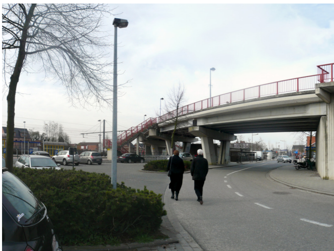
de brug over de sporen van de Boudewijnlaan
