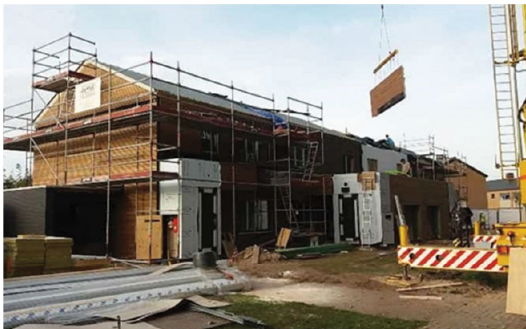
Isoleren van bestaande woningen aan de buitenzijde met prefabpanelen, Munsterbilzen, Ecoren BEN renovatieconcept
