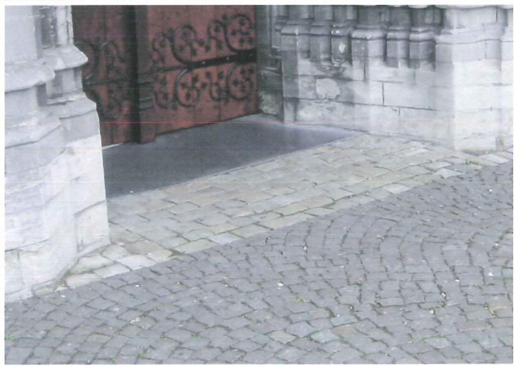
zuurstofarm gebakken steen / travertijn / natuursteen verlijmd op beton / ingang kerk O.L.Vrouw Ten Poel op de Grote Markt
