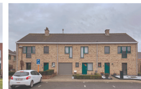
2. Woningen entree Berkenboomstraat 3 stuks, onbekend energieverbruik, eigen garage, voor en achtertuin
